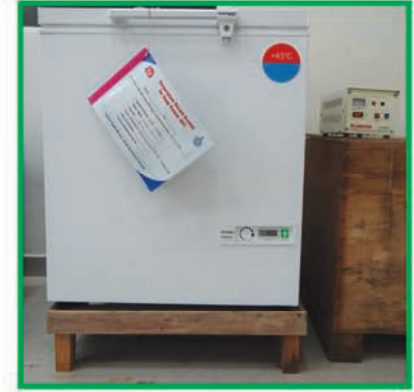
स्वतंत्र स्टेबिलाइजर और तापमान लॉग पुस्तिका के साथ लकड़ी की चौकी पर रखा डीप फ्रीजर
